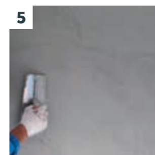
5 Aplicação da segunda camada de MICROCIMENTO MC 01
