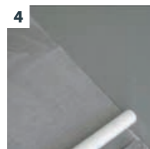
4 Embebimento da rede na primeira camada de MICROCIMENTO MC 01
