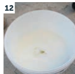
12 Adição do Componente B ao Componente A do SecilTEK AD 50
