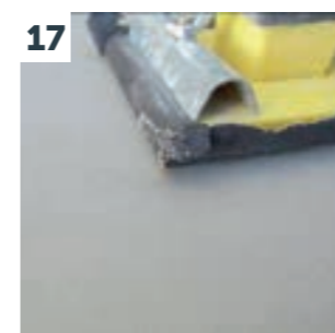
Lixagem após secagem das camadas aplicadas
