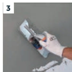
3 Aplicação da primeira camada de MICROCIMENTO MC 01
