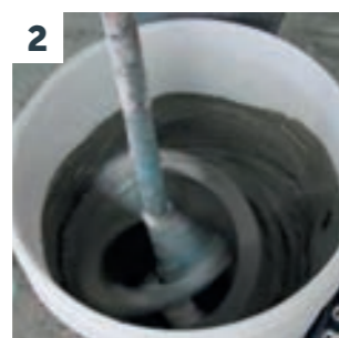
2 Mistura dos componentes do MICROCIMENTO MC 01
