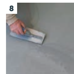
8 Primeira camada de MICROCIMENTO MC 02
